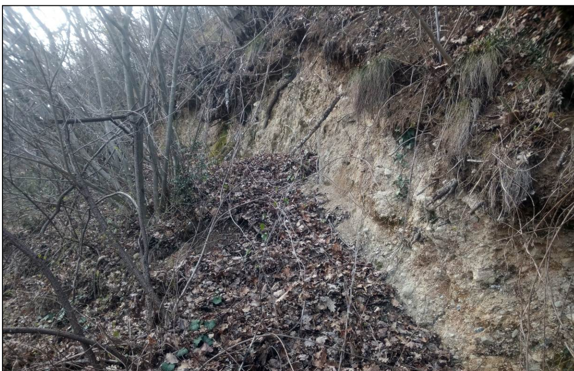
Scivolamento traslazionale attivo del ciglio di scarpata a monte del Residence degli Ulivi
